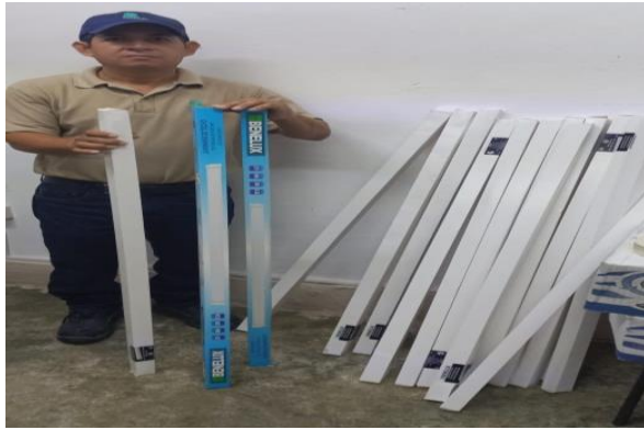
Reemplazo de luminarias por luz led de bajo consumo.
