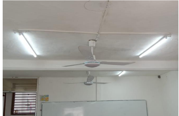
Reemplazo de luminarias por luz led de bajo consumo.
